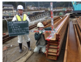
長さ約10mの鋼製矢板
