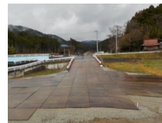
工事用道路設置
