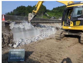
既設護岸撤去
