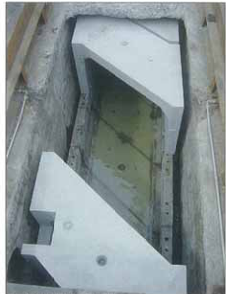
【RPC工法の投入孔】
