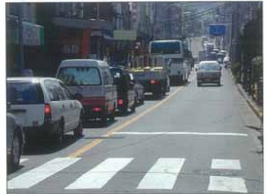
【水路に蓋掛けをした下水道管渠上の道路】
