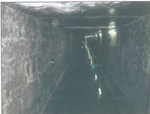
【既設管渠の内部】
