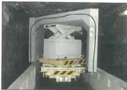
【上部ブロックの据付施工】
