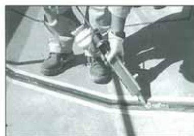
【GSシーラントの目地施工】
