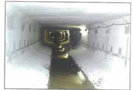
【更生後の管渠内部】
