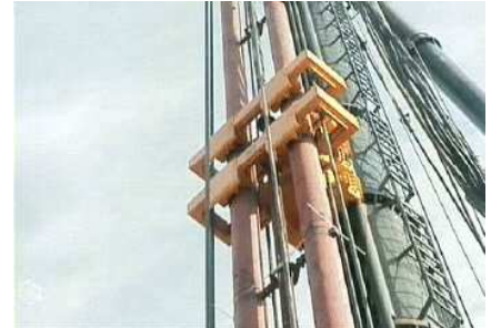
ローラ式振止とワイヤの通過状況
