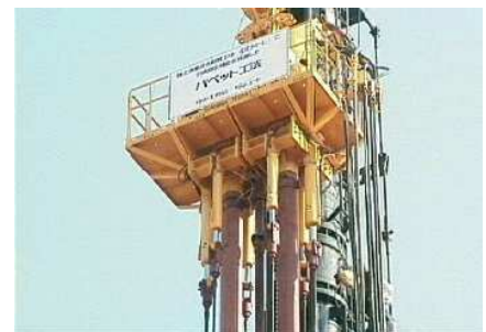
油圧ジャッキの取付け状況
