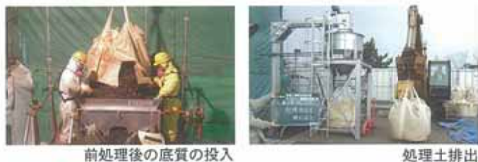
前処理後の底質の投入
