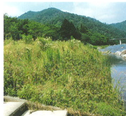
【河川護岸】別所地区緑化護岸その他工事 広島県八千代町 1998.2~3 1146m 2 1:1.2~2.0
