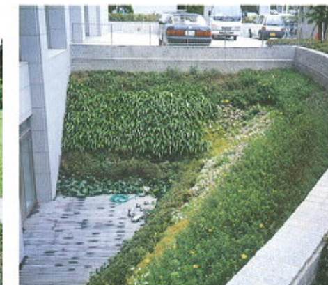
【建築外構】住宅都市整備公園関西支社新築工事 大阪市城東区 1995.2 80m 2 1:1.0
