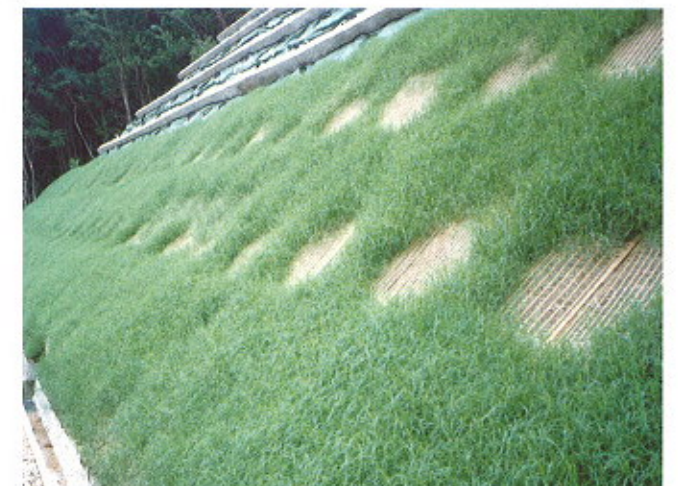
橋湾石炭火力発電所法面緑化工事 徳島県阿南市 1996.6 150m 2 1:1.0
