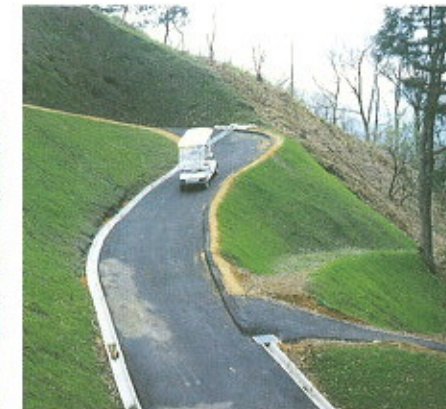
【軽量盛土法面】金沢ゴルフクラブ改修工事 石川県金沢市 1993.9 80m 2 1:1.0
