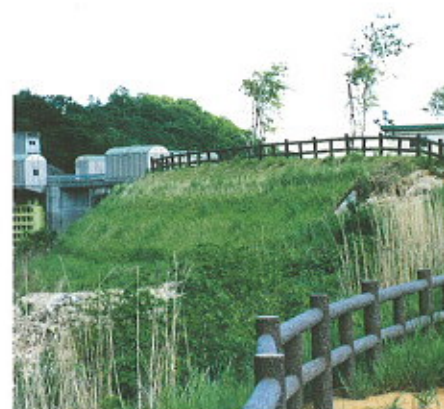
【湛水域法面】塩原ダム周辺環境整備工事 栃木県塩原町 1995.10~11 110m 2 1:1.0
