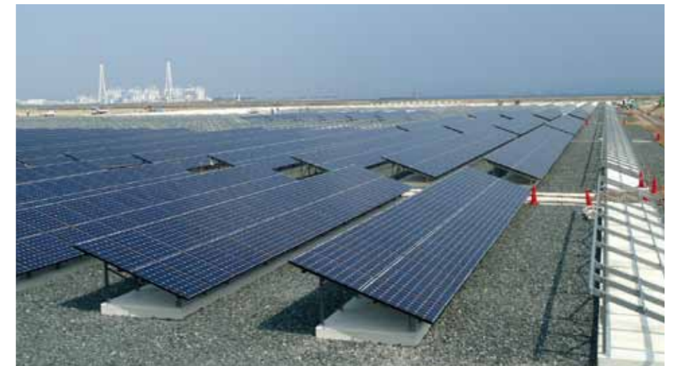
中部電力「メガソーラーたけとよ」工事風景
