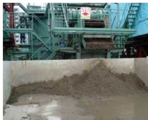
土壌洗浄プラント/分級状況
