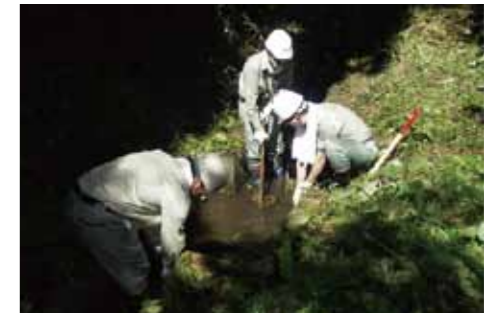
「岩手中部土地改良区」用水路の泥上げ活動
