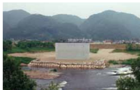
フライアッシュコンクリートによる橋脚の施工
